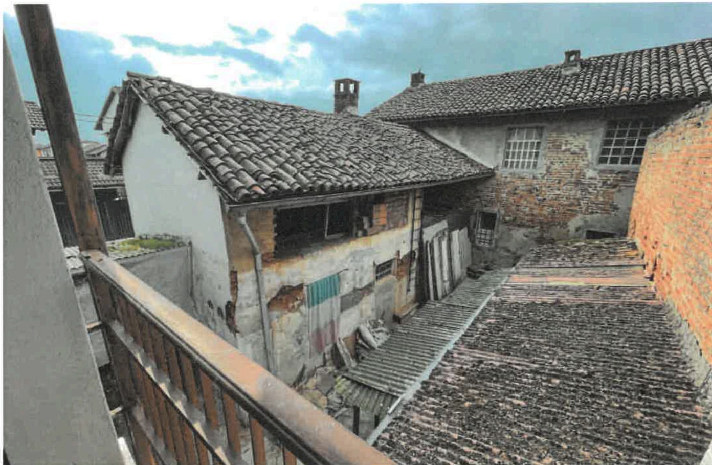
Il cortile interno il corpo magazzini-depositi e la copertura del corpo non accatastato e autorizzato Caresana
