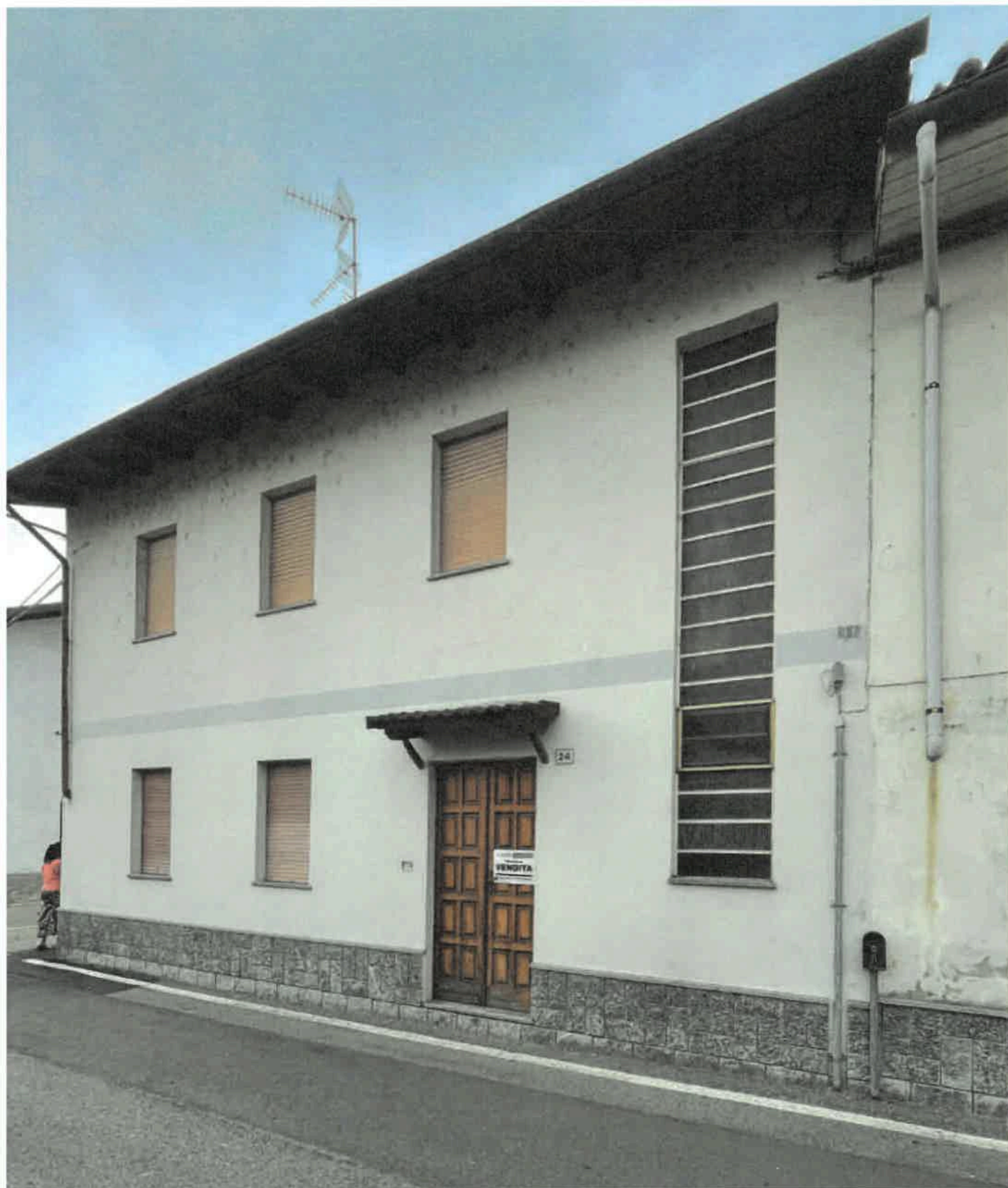
L'ingresso Pedonale di Via Camillo Benso di Cavour n.24 - Caresana
