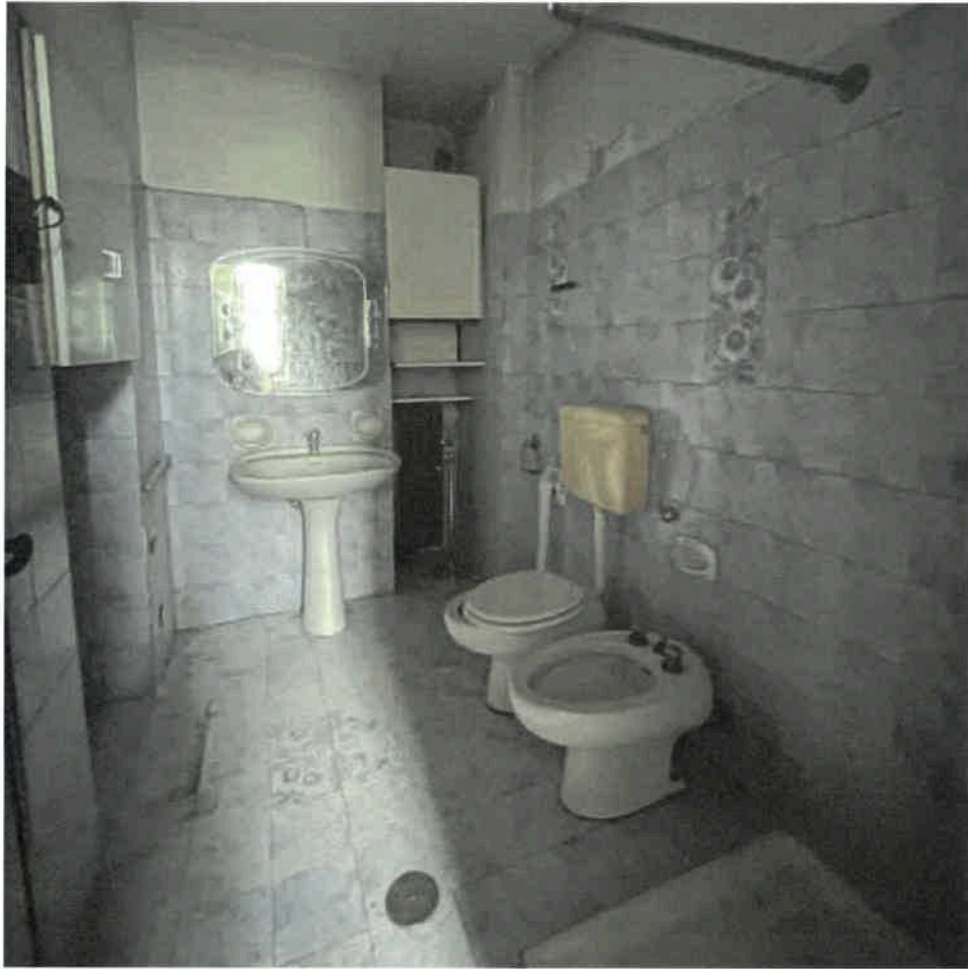
Servizio Igienico al Piano Terreno Caresana
