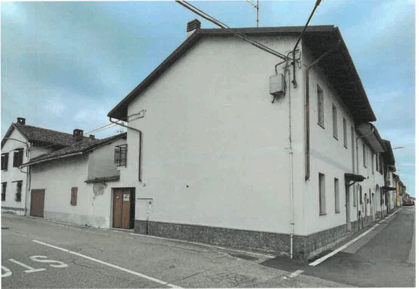
L'angolo con Via G. Marconi e il secondo ingresso Pedonale e Carraio - Caresana
