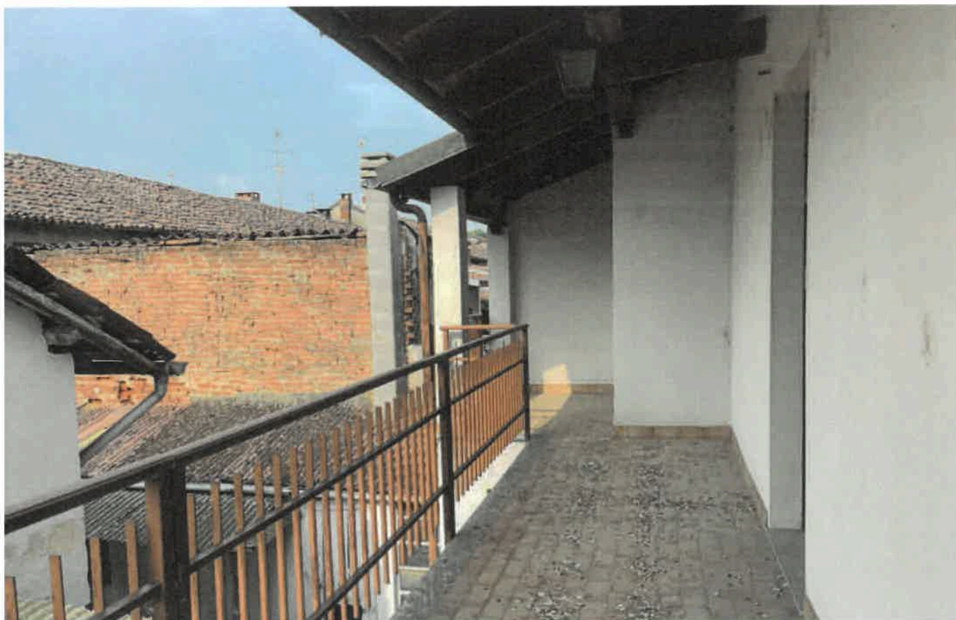
Il terrazzo che si affaccia sul cortile interno- Caresana -
